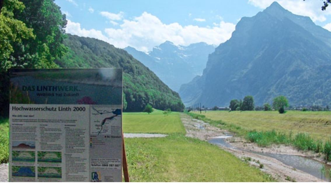
Entlang dem Escherkanal entstand 2009 am Eingang zum Glarnerland in der ersten Phase der Hochwasserschutzmassnahmen ein neues Feuchtgebiet, welches zugleich das Hauptgewässer entlasten kann. · En 2009, au cours de la première étape des mesures de protection contre les crues, une nouvelle zone humide s'est formée à l'entrée du pays glaronnais, capable si nécessaire de délester la rivière principale.
