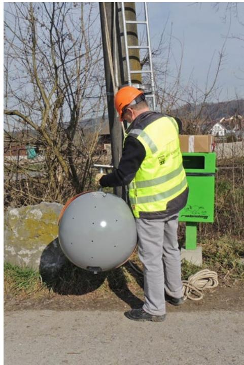
*Abwehrmaßnahme auf einem gefährlichen Strommast. · Dispositif dissuasif sur un pylône dangereux.*
