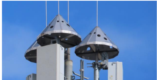
Genügend grosse Kegel verhindern Horstbau auf Kaminen und Antennen.
