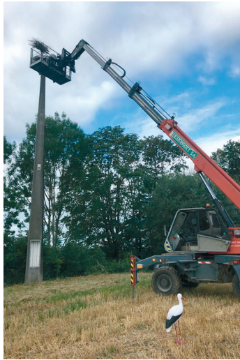
Erstellung der neuen Horstplattform bei Missy. Installation de la nouvelle plateforme près de Missy.
