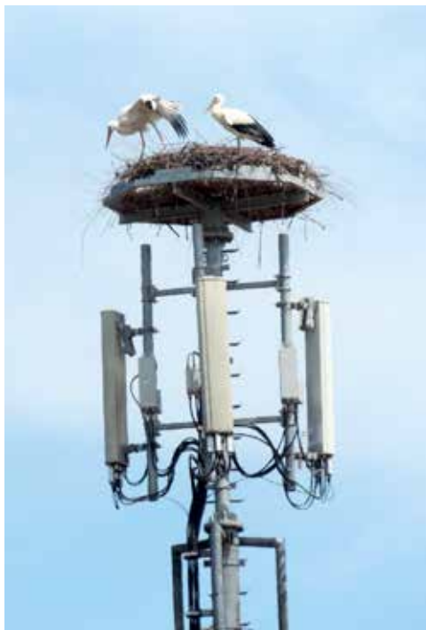
Erfolgreiche Brut auf Natel-Antenne mit Plattform, Jungstorch kurz vor dem Ausfliegen. Nidification avec succès sur une antenne munie d'une plateforme avec un cigogneau proche de l'envol.
